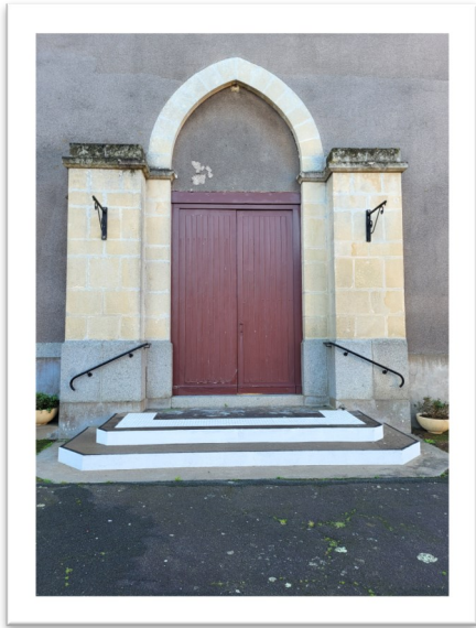
Accessibilité de l'escalier de l'église
